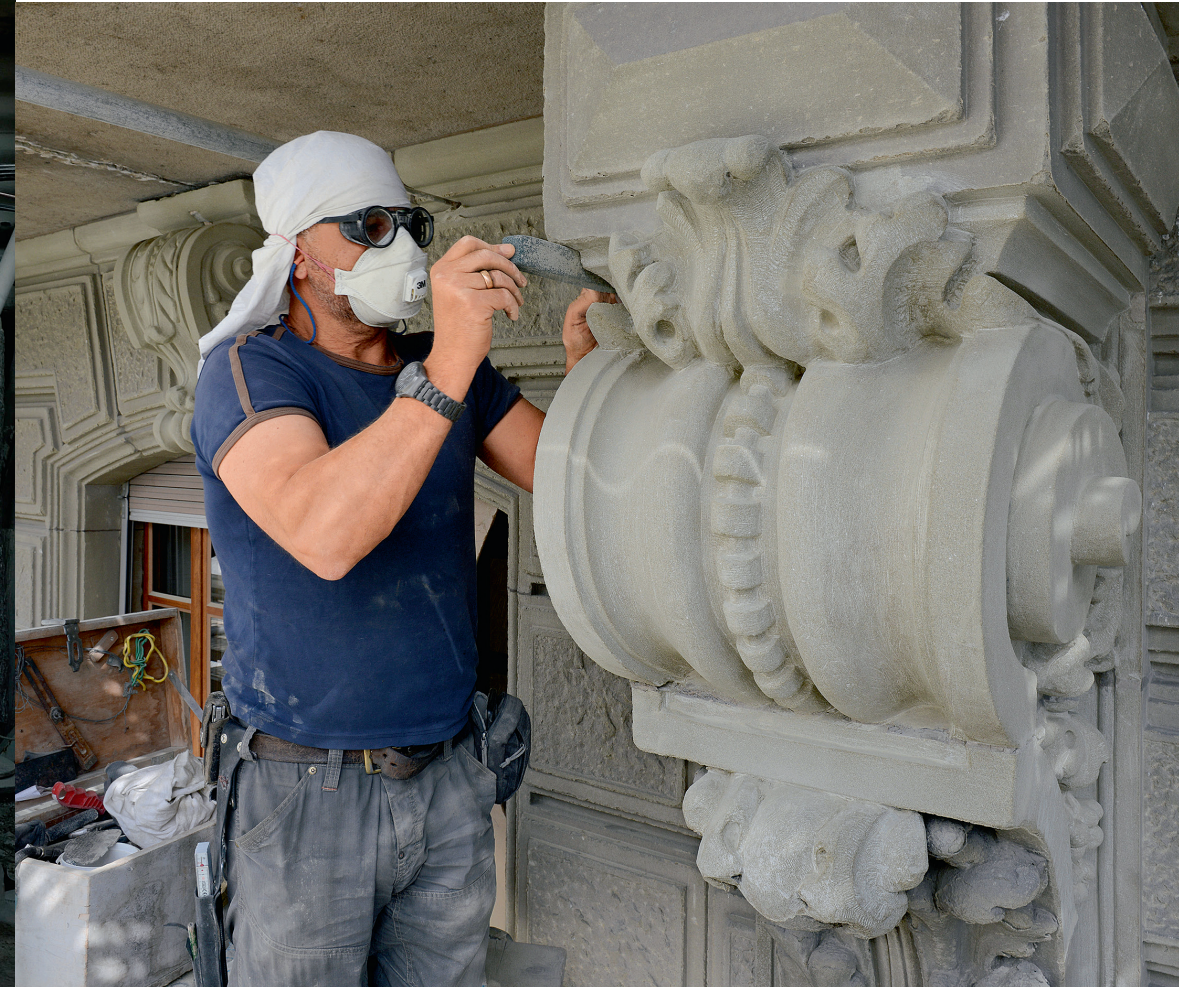
Restauration par retaille d'un ornement de façade en molasse, au 15, quai de l'Île à Genève.
